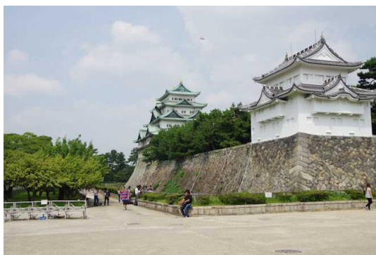
写真4 名古屋城天守閣の眺め (上) 本丸御殿の工事中 (下) 工事完了後
