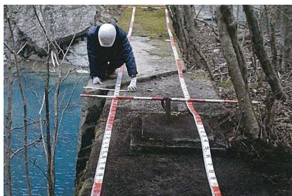
(写真4 平谷床固工袖部の斜め縁切り)
