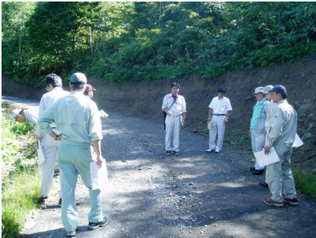
写真-2 検討状況、路盤と切土法面
