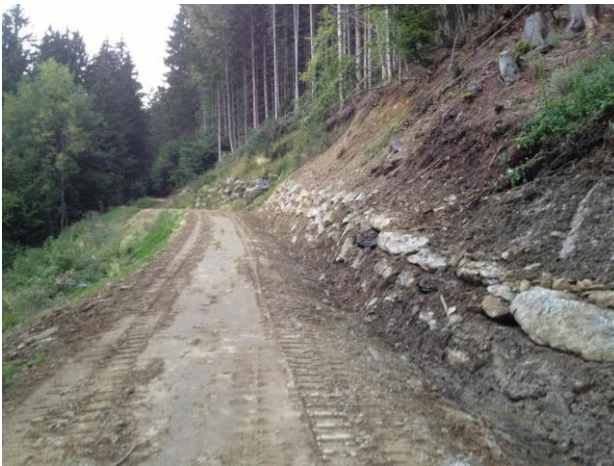
写真一一 林道法面の安定化処理
