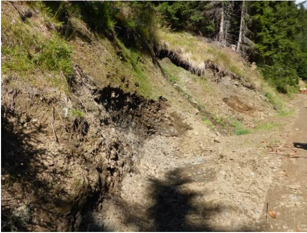
写真一〇 林道の法面の崩落
