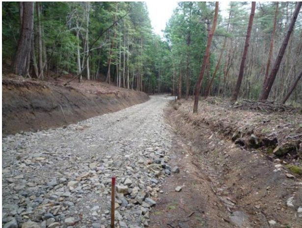
写真一11 路盤材を工夫した林道の事例 (長野県 大町市)
