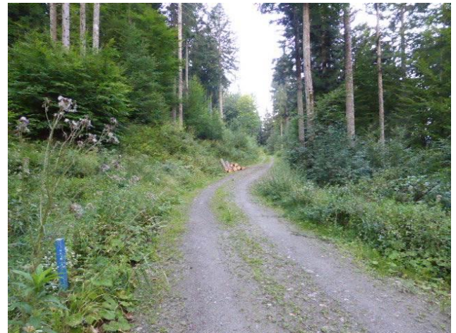
写真一2 林道の整備状況
