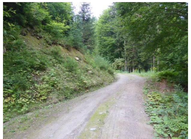
写真一八 林道の維持管理状況 (側溝の土砂除去)
