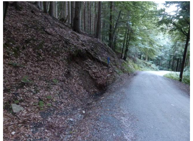
写真一七 林道の維持管理状況 (暗渠受け口の土砂除去)
