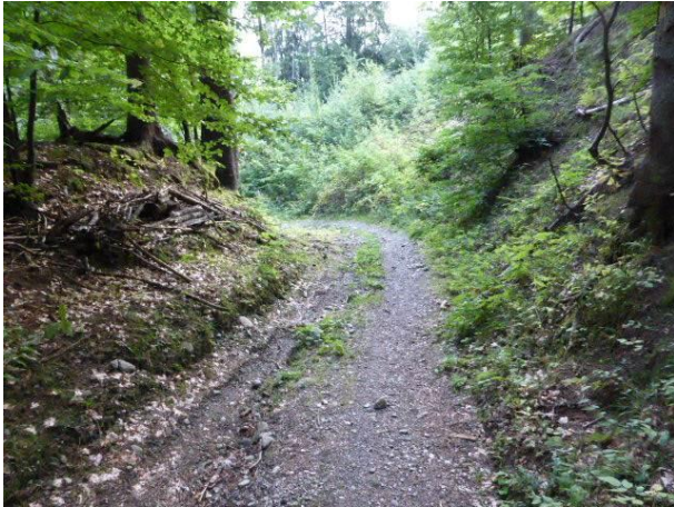
写真一五 林業機械用路 (簡易な土路 ; Rückewege)
