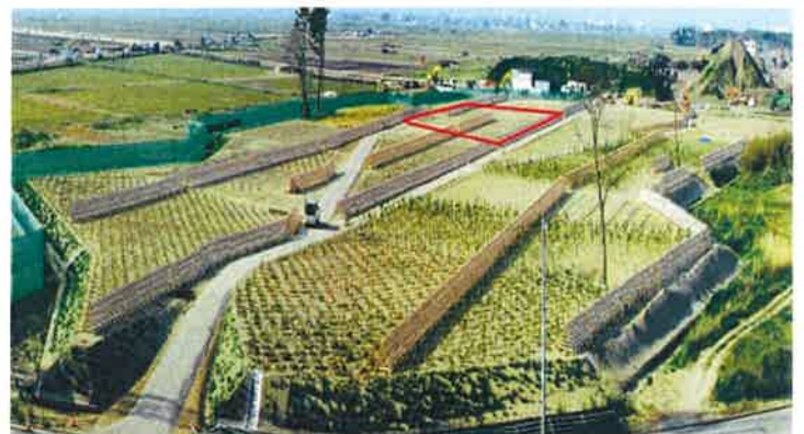
写真 10.4 荒川国有林の復旧状況(平成 25 年 8 月) 【東北森林管理局資料より】
