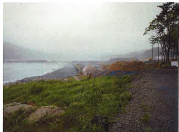
写真 8.3 防潮堤の復旧工事中、植栽は地元から農地の提供や換地手続終了後となる。
