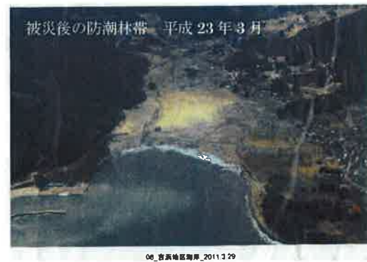
写真 8.2 1m の地盤沈下により防潮林は水没。新設の農地防潮堤は 30m 後退した位置に建設中。
