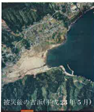
写真 8.1 吉浜地区の被災前後 浜が消失している。
