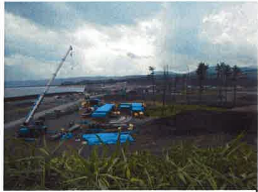
写真 2.8 残存する防潮林、堤の後背部は盛土して植栽
