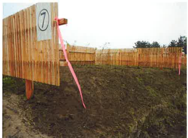
写真 12.3 黒土を敷き均したケヤキ、コナラ植栽区
