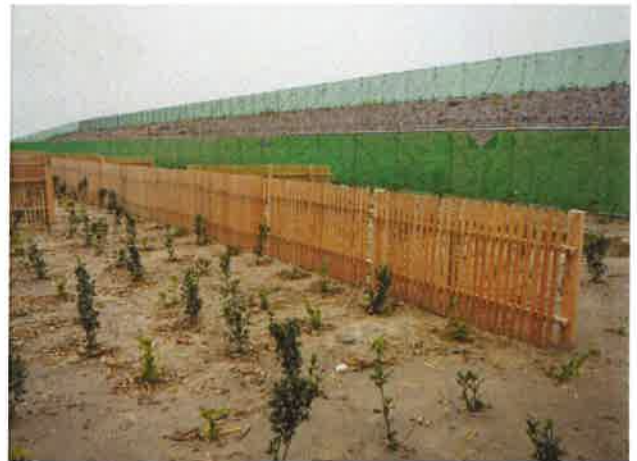
写真 11.2 緑の防潮堤背面の植栽状況 (緑色の防風ネットの中)
