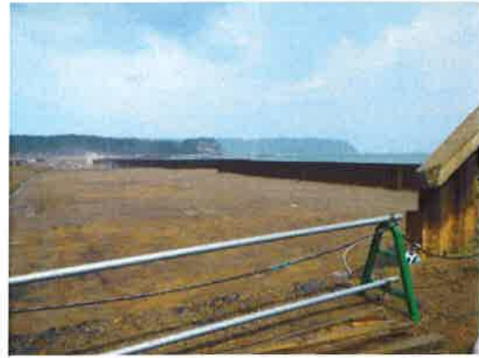
写真 2.7 第3区間全景(新設)
