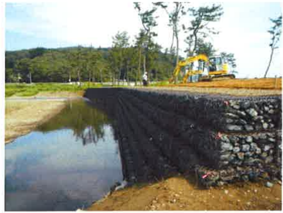
写真 1.3 鉄線籠型護岸工 (夏井川側)
