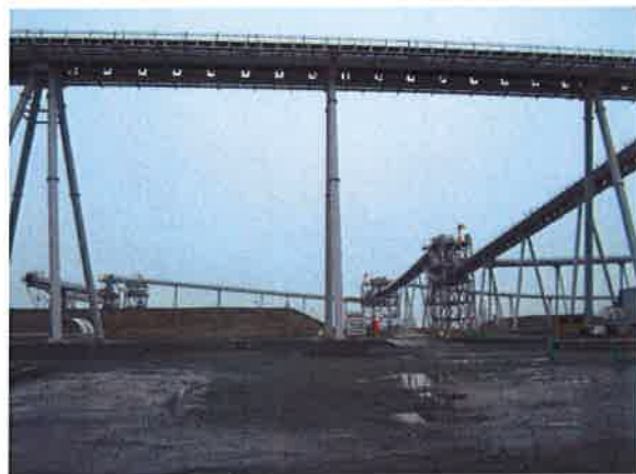
写真 9.8 復旧状況 気仙川対岸の宅地造成現場からの土砂を市街地の嵩上げや第二線堤造成用に利用するためベルトコンベアで搬送中。
