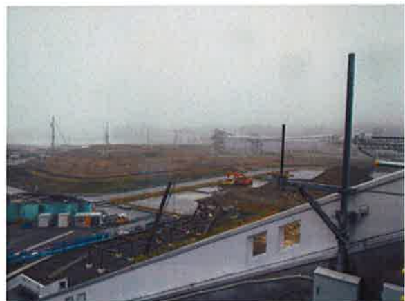
写真 9.9 復旧状況 第二線堤の造成工事中。
