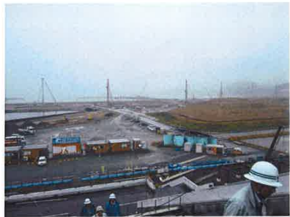
写真 9.7 復旧状況 第1線堤、第2線堤を遠望
