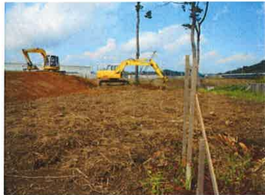
写真 1.4 盛土の造成 (丁張の天端まで盛土を行う)
