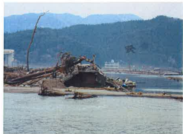
写真 9.3 被災した第二線堤
