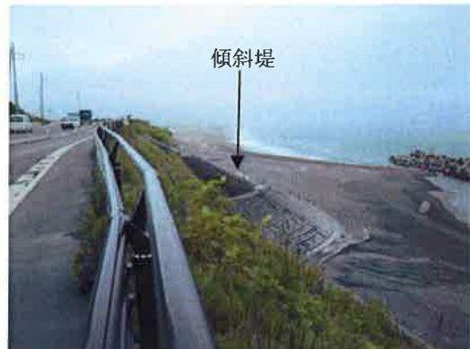
写真 2.10 周辺の海岸施設＝被災を受けなかった傾斜堤
