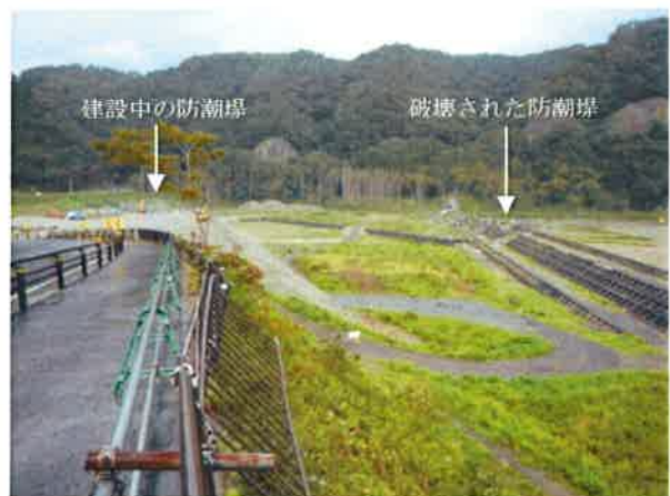
写真 3.4 被災した防潮堤の陸側に道路を兼ねた防潮堤を建設中。旧防潮堤は保存されて公園として整備を予定している。
