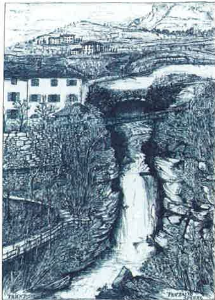
図-1 最古の土砂流出防止堰堤 (Pont-alto-Sperre) (オーストリア農林省編：砂防 100 年史、1984)
