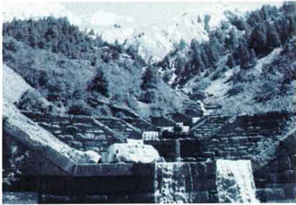
図-26 ブレッターヴァントバッハ上流堰堤工
