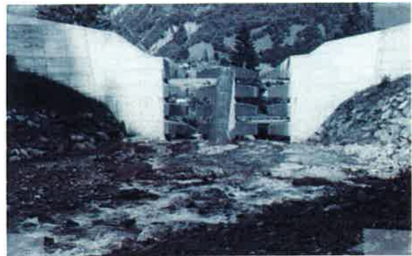
図-29 流出土砂量調節用のスリット堰堤
