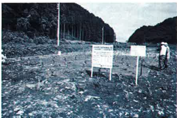
写真6 岩手県宮古市摂待試験地の植栽状況
