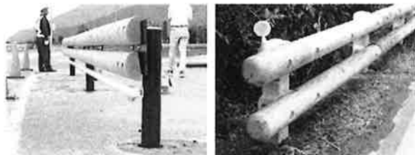
1号型 3号型 図7 木製ガードレール
