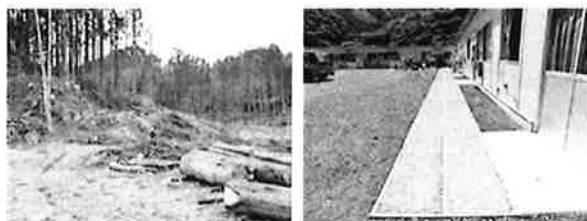
原料の津波塩害木 木材チップ舗装歩道
