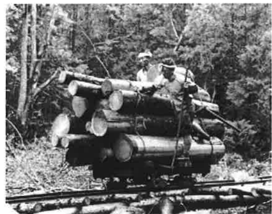
写真1 台車の自重で乗り下げる豆トロ軌道
