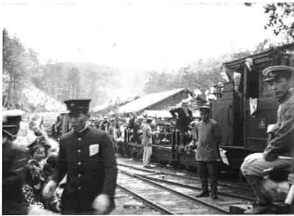
写真4 大正9年の御造営材の運搬風景
