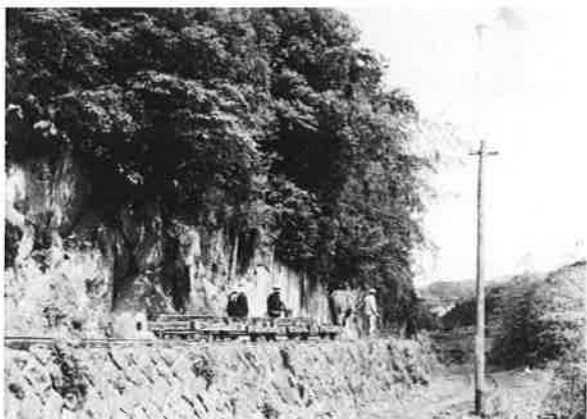
写真3 馬力による空台車の引き上げ
