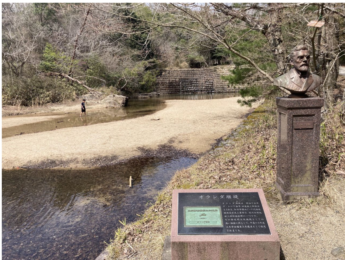
オランダ堰堤(土木遺産に認定)
